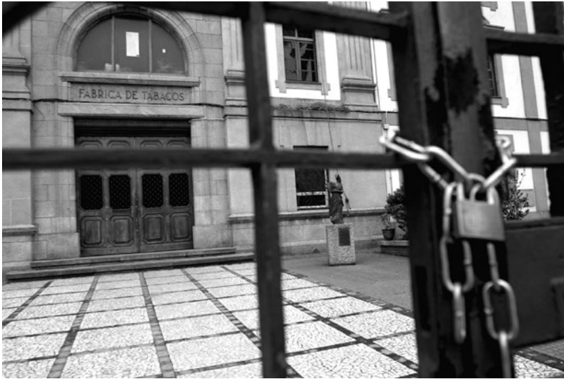
Porta de entrada da Fábrica de Tabacos. Fotografía de Xosé Castro.
