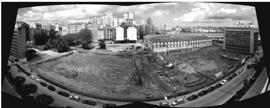
Obras no soar da Fábrica de Tabacos 19/06/07. Fotografía de Xosé Castro.
