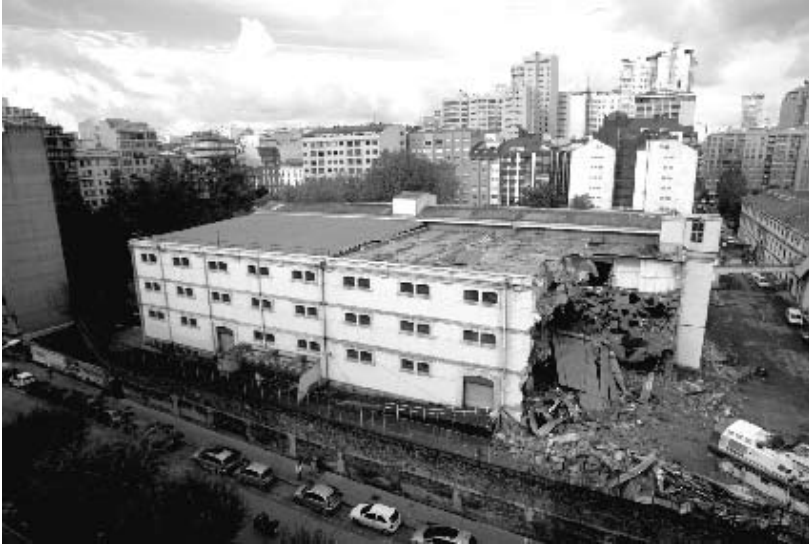
Obras de derrubamento das dependencias da Fábrica de Tabacos 04/10/06. Fotografía de Xosé Castro.
